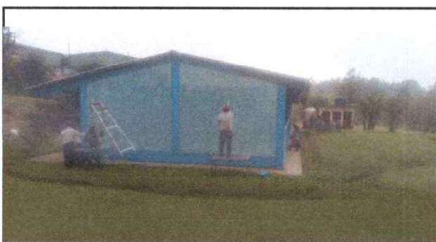
Foto 5: pintura de la escuela en diferentes ambientes
