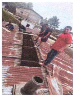
Foto 3: Cambiando techo en mal estado, Se filtra agua en todo el invierno
