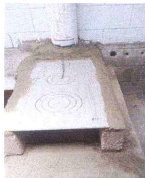
Foto 4: Reparación de la plancha, pollo en mal estado,
